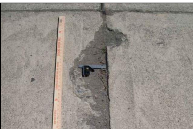
Spalling
